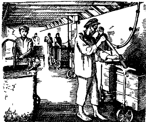
Рис. 1. Приготовление развозных грязевых ванн с помощью паронагрева.
